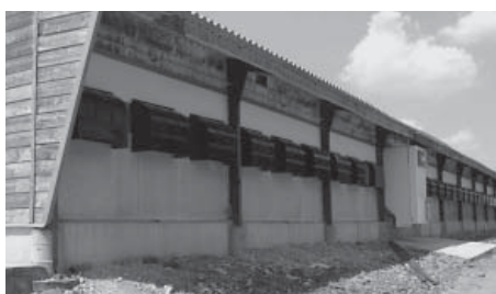
Poulailler "Louisiane" transformé en "Colorado", avec des trappes dirigeables et des échangeurs de chaleur (Maine-et-Loire).
